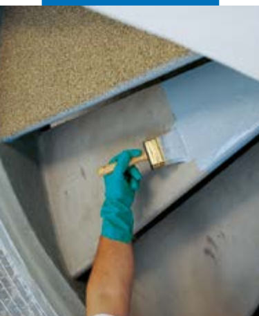
Aanbrengen van Mapecoat I 24 op beton
