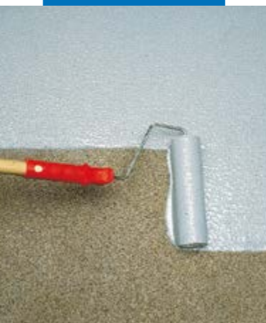
Aanbrengen van Mapecoat I 24 met een roller
