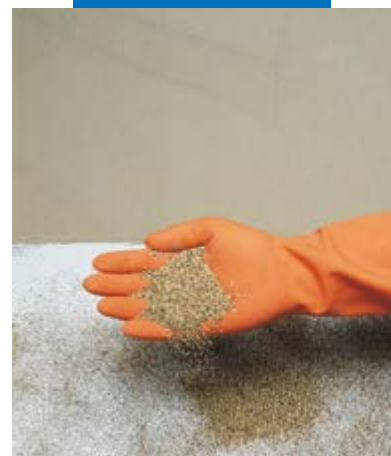
Dun laagje droog zand op de natte laag Mapecoat I 24
