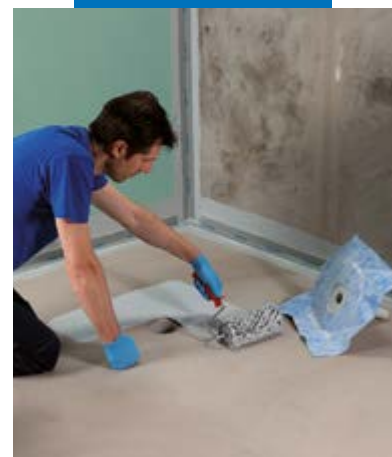
Aanbrengen van een verticale afvoerput met Mapegum WPS
