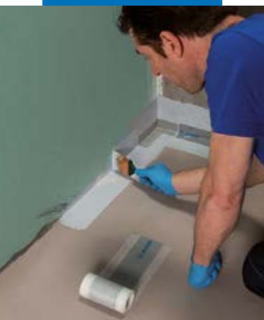
Aanbrengen van Mapeband PE 120 met Mapegum WPS
