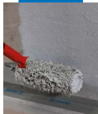
Aanbrengen van Mapegum WPS met een roller
