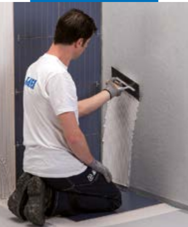
Aanbrengen van wandbekleding met Keraflex Maxi S1
