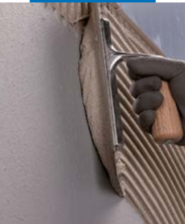
Aanbrengen van vloerbedekking met Ultramastic III
