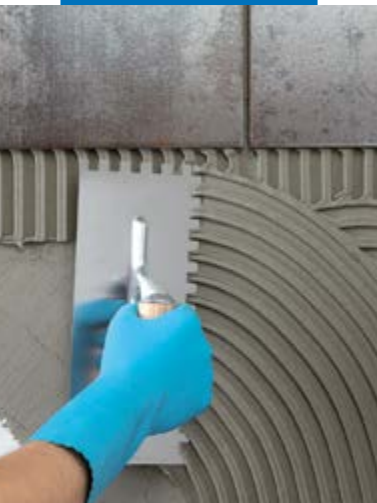
Aanbrengen van Ultralite S1 met een getande lijkam
