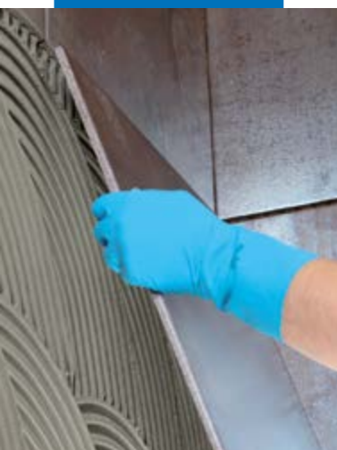
Plaatsen van groot formaat tegels op wanden
