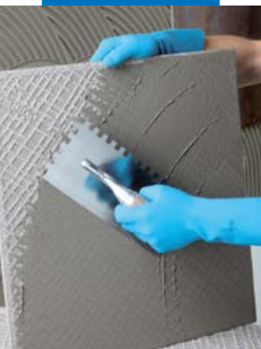
Aanbrengen van de lijm op de achterkant van de tegel
