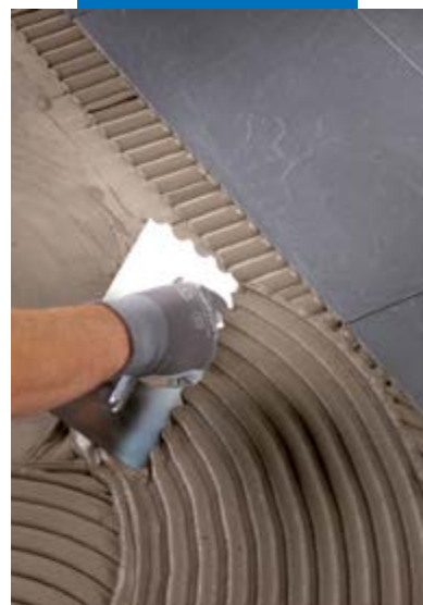
Het aanbrengen van de lijm op een vloer met een 9 mm rond getande lijmkam
