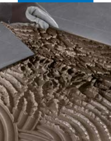
Controleren van de volledige back-buttering methode op dunne porselein gres tegel
