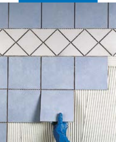
Aanbrengen van enkelgebakken tegels op een gipsplaten wand
