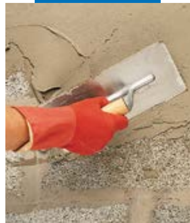
Met een spaan aanbrengen van Planiseal 88
