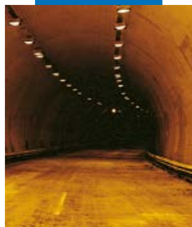
In een verkeerstunnel opspuiten van Planiseal 88 wit
