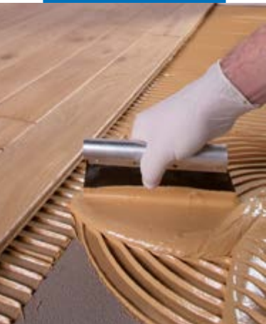
Verspreiden van Ultrabond P990 1K
